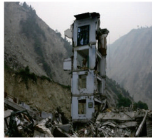
(b) 汶川地震造成的结构破坏
